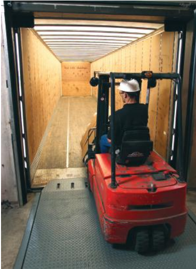
Gewöhnliche Planentorabdichtungen lassen Lücken an Auflegertürscharnieren unabgedichtet.
